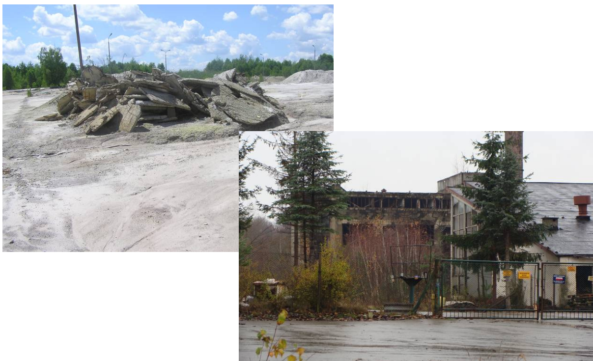
Fotografia 2. Ruiny budynku i placu składowego byłej Kopalni Siarka w Baszni Górnej
